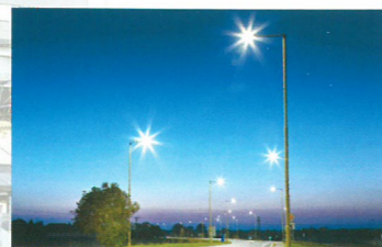
外灯取付工事
