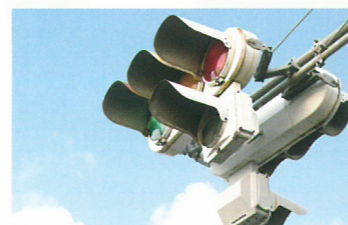
信号機設備工事
