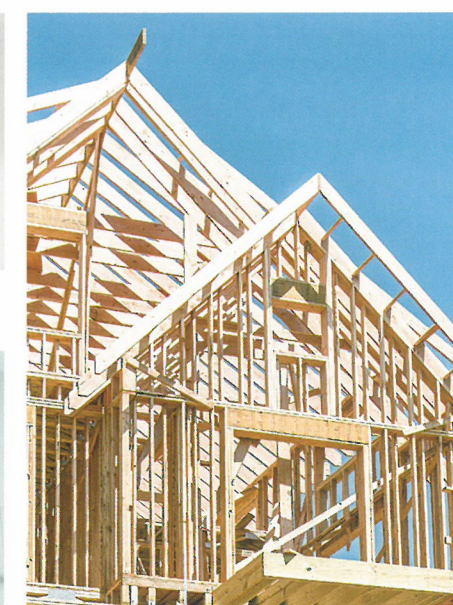
新築・増築・改築工事 など
