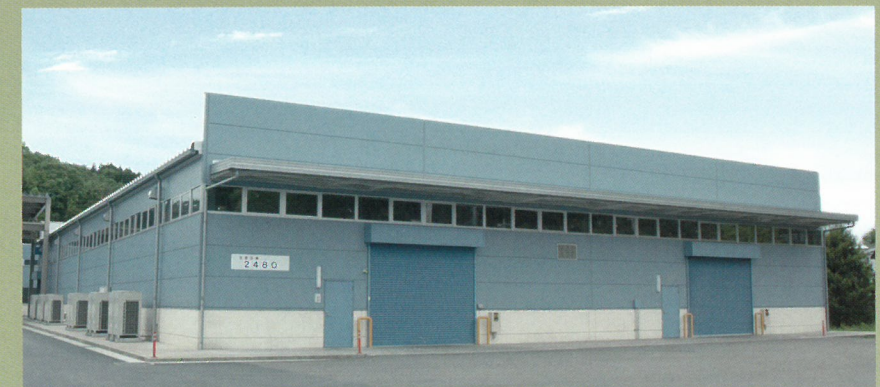
■ 福島工場 シャフト切削工場
