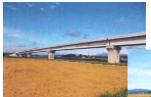
■神林高架橋 神林高架橋は新潟県村上市九日市の百川から下助淵の石川までの橋長1,452mの高架橋である。この区間には四つの河川と県道、JR羽越線など多くの交差物がある高架橋のひとつである。
