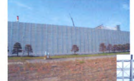
■高性能薄型防音パネル さまざまな音の伝達から生活環境を守る半板で優れた吸音性・遮音性の両性能を発揮すると同時に、軽量で高強度、耐久性・施工性に優れた高性能防音壁です。
