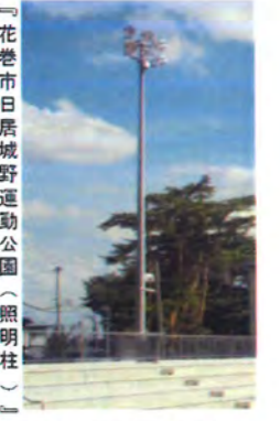
■THP, S-THP 防災アンテナ用、照明用のコンクリート継柱。地上高25mまで対応。運搬性を考慮し2分割式。
