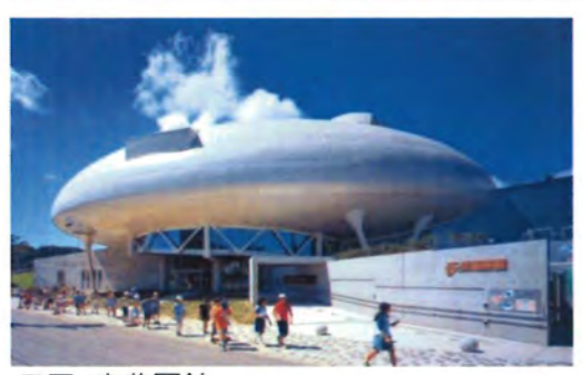
■石ノ森萬画館 石巻市の真ん中を悠々と流れる東北一の大川である北上川。その河口近くの三角州にぽっかりと浮かんだ飛行船、それが石ノ森萬画館。東日本大震災による地震と津波で被災したものの、建物自体は、耐え抜いた。※杭打工事で使用する杭打機および製品（パイプ）は、すべて女川港からの海上輸送で対応。
