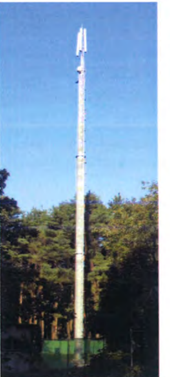
■フレックスポール (FXポール) 地上高30m~40mまで対応可能。設計荷重が30~40kNで、3~6分割することで運搬性能を向上。 (写真: 移動通信関連アンテナ局)
