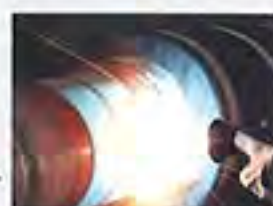
①軸部の修理作業
