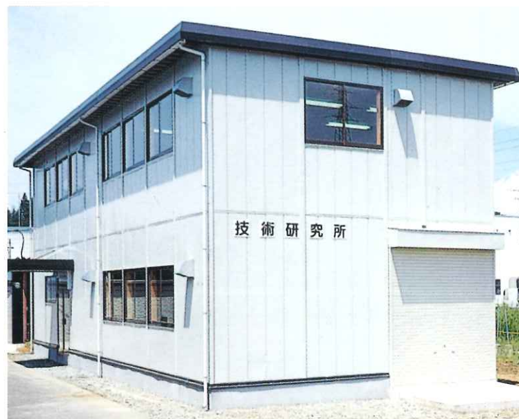
技術研究所 Technical Research Center
