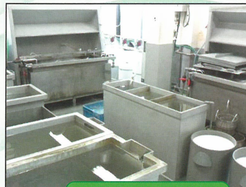
メッキ処理設備
