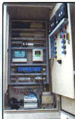
遠隔制御盤
